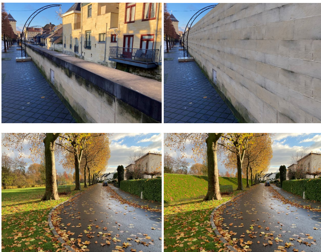
Figuur 5.20 Impressie van de verandering in het centrum van Valkenburg (boven) en bovenstrooms van het centrum (onder) door de aanleg van 3 m hoge kademuren (bron: Provincie Limburg)
