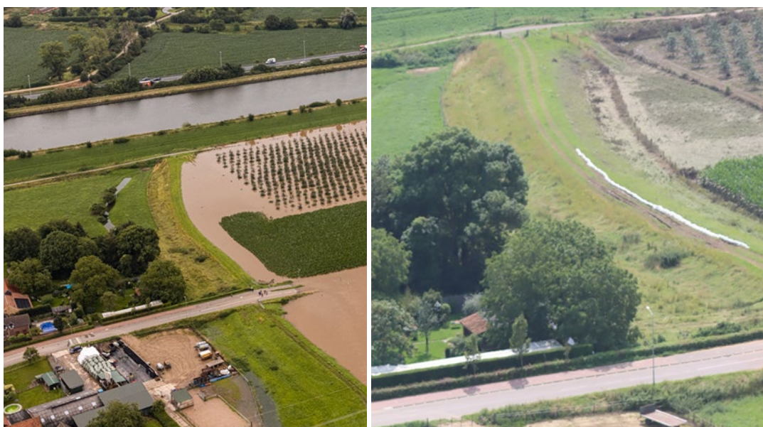
Figuur 9.5 Luchtfoto's van de waterkering aan de zuidzijde van dijktraject 82-1. Links: op 16 juli 2021 (tijdens het hoogwater); rechts: op 19 juli 2021 (na afloop van het hoogwater)
