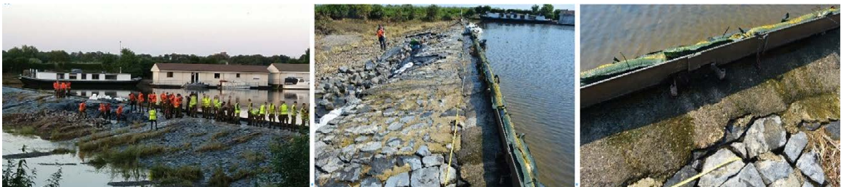
Figuur 4.8: Stuw bij Bosscherveld: noodreparatie met assistentie van het leger (foto Wilbur van Beijnen, Rijkswaterstaat), overzicht kring na reparatie (vloedmerken nog zichtbaar bij de begroeiing op de achtergrond), detail verankering stalen rand.
