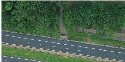
1 – Onderdoorgang A79 volgelopen
