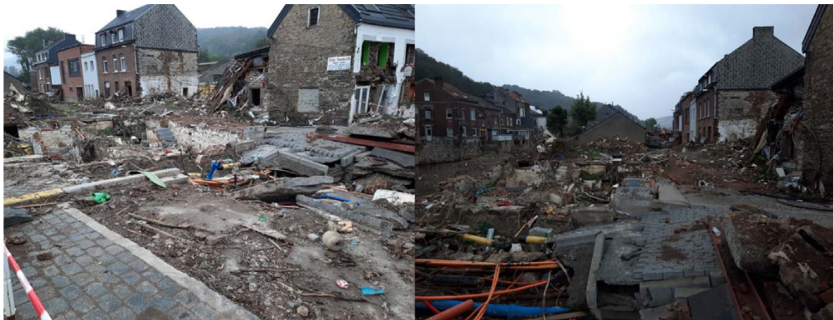
| Figuur 8.3: Schade aan wegen en gebouwen in Pepinster (Bron: Deltares collega's, genomen tijdens GEER-missie.)
