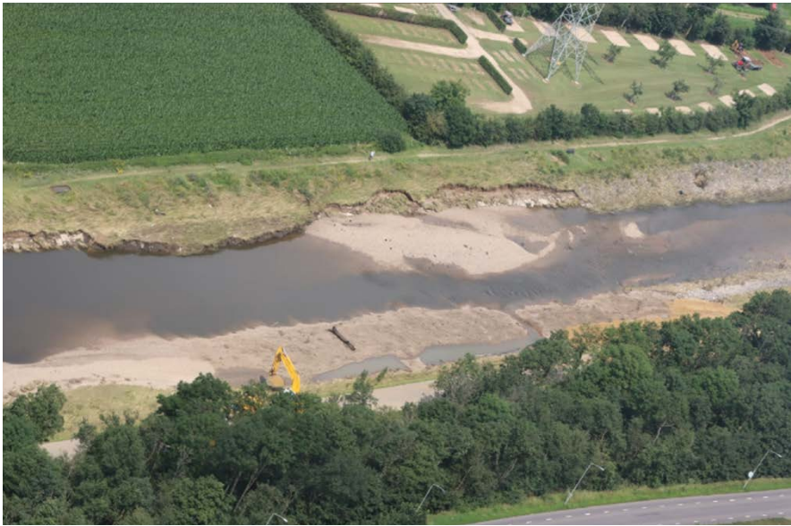
Figuur B.3.6.2: Helikopterfoto herstelwerkzaamheden
