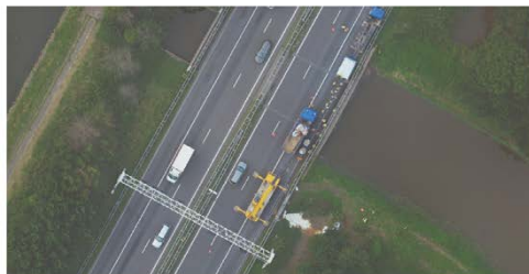
7 – Stremming A2 i.v.m. plaatsen zandzakken
