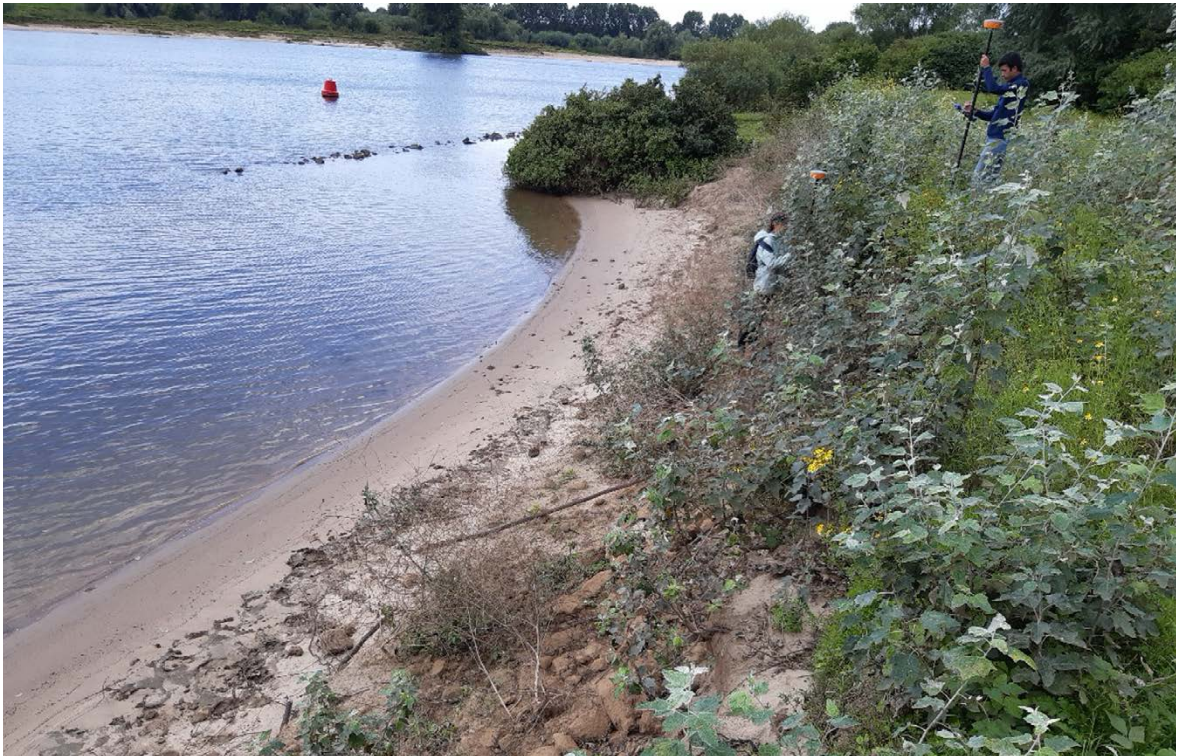
| Figuur B.3.4.8: Benedenstreams brug A2, rechteroever, binnenbocht (geometrie erosie wordt ingemeten door WUR)
