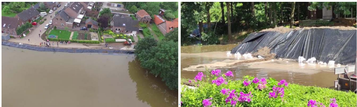
| Figuur C.3.1 Nooddijk bij Horn 26 met de latere doorbraaklocatie bij de shovel, en het begin van de doorbraak 27 .
