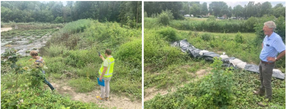
Figuur C1.1: Waterbergingsgebied De Dem met op de linkerfoto rechts onder de vermoedelijke uitstroomblocatie, op de rechterfoto op de voorgrond de sporen van erosie van dezelfde locatie.
