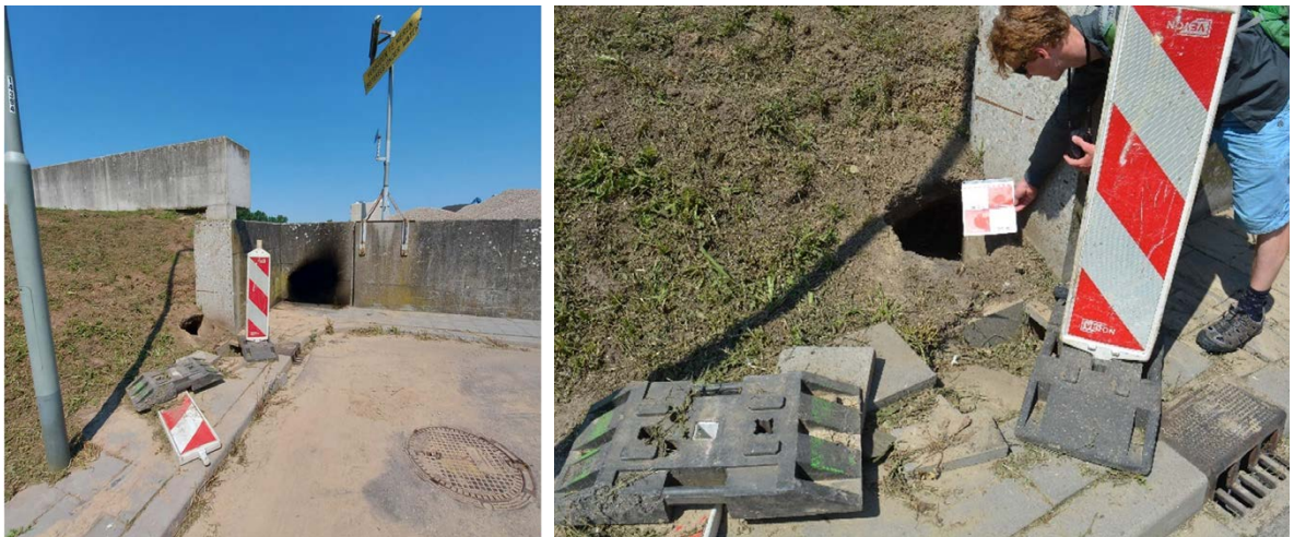
Figuur C.5.1: Sporen van een wel bij de overgang van twee verschillende keermuren: overzicht (links), detail van het achtergebleven gat (de rood-witte blokken zijn elk 10 bij 10 cm) (rechts).
