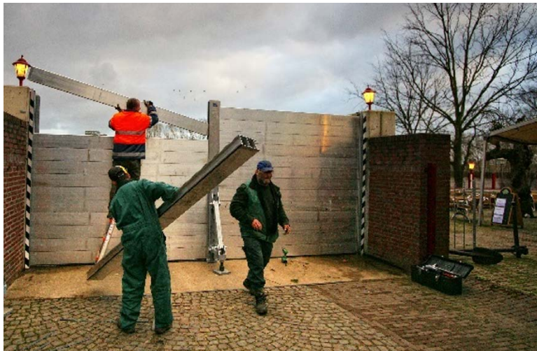
Figuur 7.5: Demontabele kering bij Steyl (tijdens oefening)
