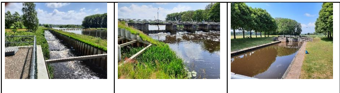
Afbeelding 16: Vistrap (links), stuw (midden) en vaarsluis (rechts) op de Vechte (foto's Marnix van der Vat)
